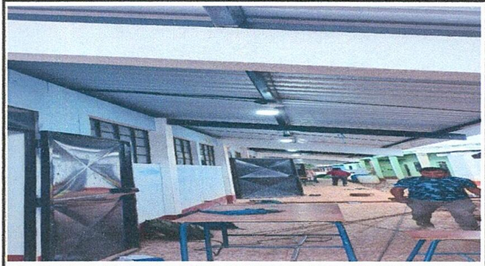
Foto 2: Reparación de sistema eléctrico
