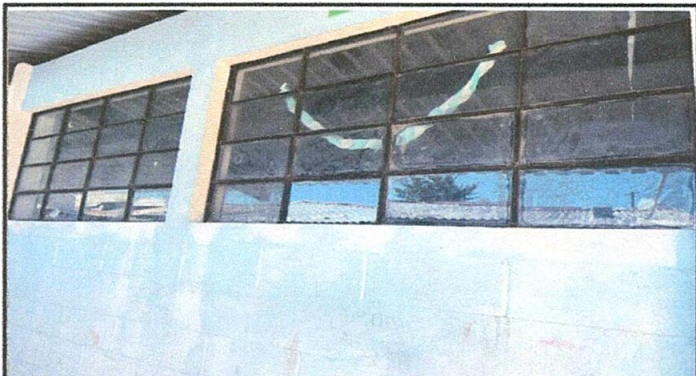
Foto 4: Sustitución de Vidrios
