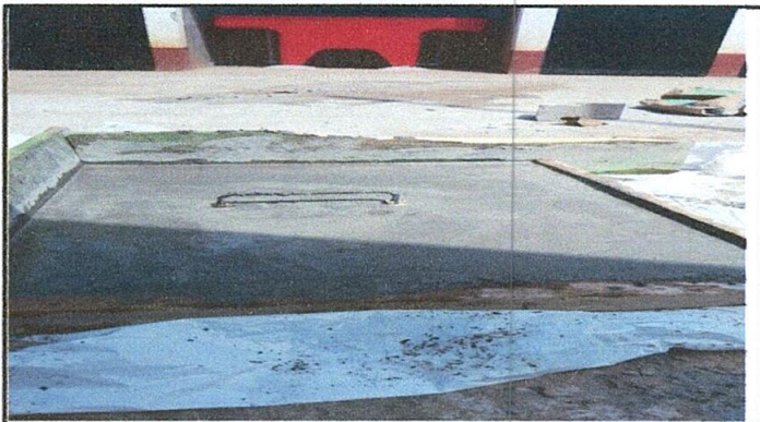
Foto 3: Mantenimiento y reparación de fosa séptica
